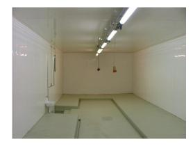
Die Paneele eignen sich für kostengünstige, fugenlose Decken- u. vor allem Wandverkeidungen, in Feucht-, bzw. Nassräumen. (Hochdruckreinigung möglich).
