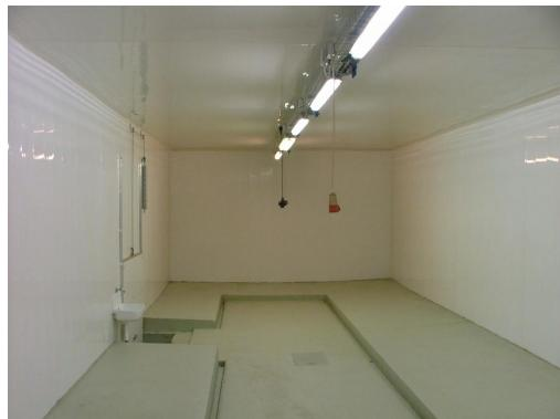
**Die Paneele eignen sich für kostengünstige, fugenlose Decken- u. vor allem Wandverkleidungen, in Feucht-, bzw. Nassräumen. (Hochdruckreinigung möglich).**
