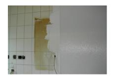
vollflächige Verklebung von großformatigen Platten / Paneelen auf ebene, tragfähige Untergründe für starke Beanspruchung
