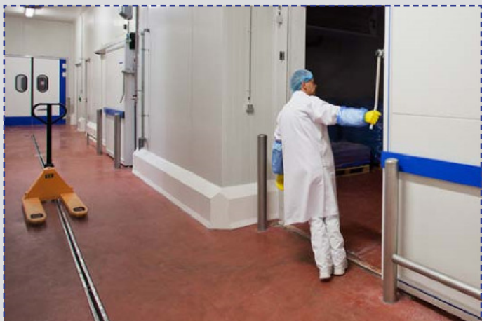
PolySto IP40F Sanicoat montiert auf einem Betonboden und Edelstahlpfosten und Barriere in einem Betonboden verankert.
