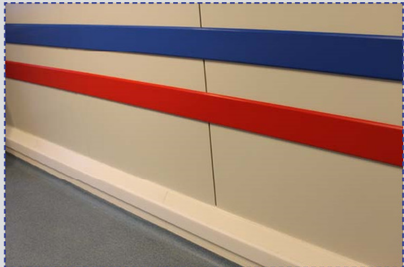
PolySto OP30RB (optional extreme Impact) mit einem Epoxyboden in die Aussparung eingearbeitet und roten und blauen PE-Streifen an der Wand.
