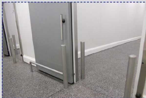
Eingebaute PolySto Edelstahlpoller und -barriere und OP30RB Sanicoat mit einem Granitboden in die Aussparung eingearbeitet.
