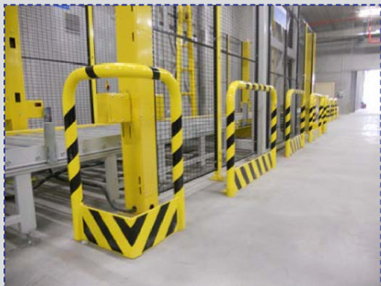
PolySto PMA (links) und PML (rechts) montiert auf einem Betonboden.
