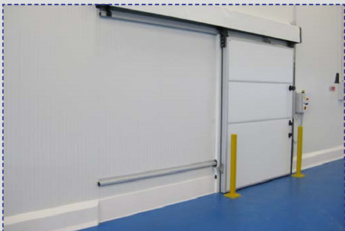
PolySto OP30F, OP30SF Sanicoat und Polyurethan-Pfosten montiert auf einem Epoxy-Fussboden
