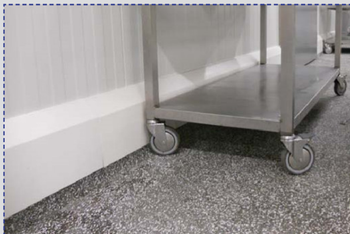
PolySto OP30RB mit einer Granitboden Hohlkehle in die Aussparung eingearbeitet.
