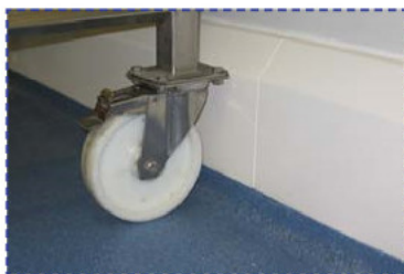
PolySto OP30RB Sanicoat mit einer Epoxy-Hohlkehle in die Aussparung eingearbeitet.
