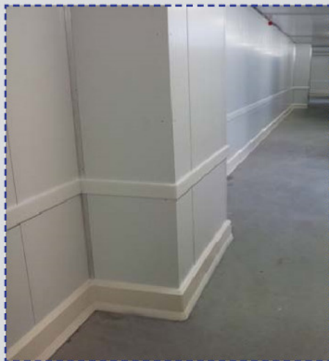
PolySto OP20F auf einem Betonboden montiert mit PE-Streifen.
